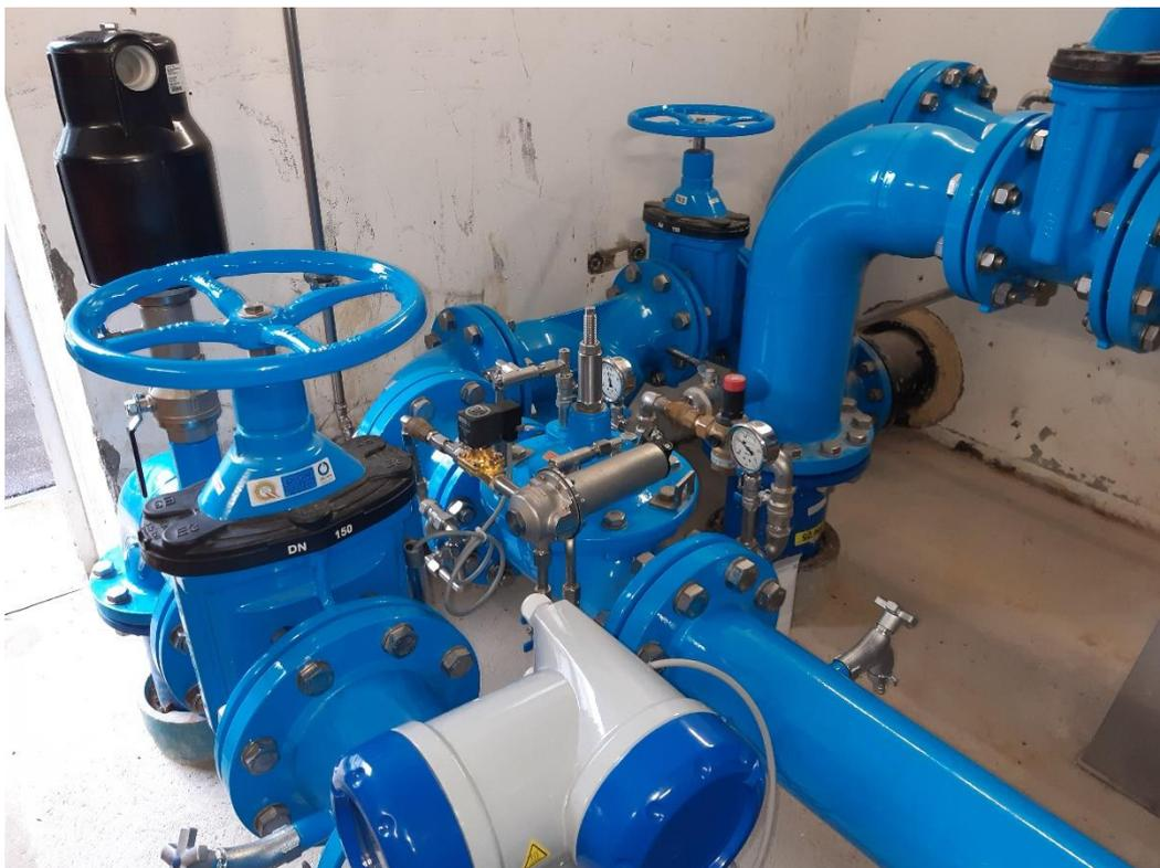
Cette infrastructure est capable d'assurer la consommation moyenne en journée des deux communes soit env. 350l/min. Il s'agit du dernier élément de l'alimentation en eau potable du Syndicat qui va servir en cas de problème sur la conduite principale reliant la station de la Raisetette au réservoir de SolBoz ou au réservoir lui-même.
